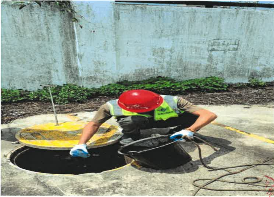
图 2：上游管网排查取样
